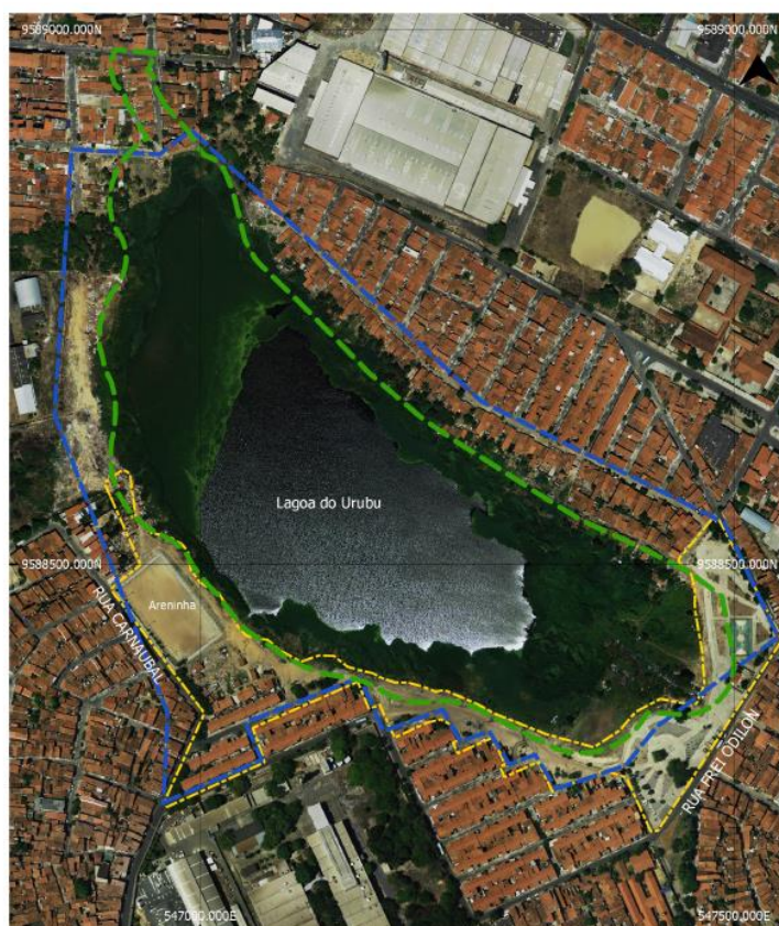
Imagem 01 – Área de intervenção Lagoa do URUBU; fonte: Google Maps
